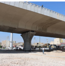
پل شهدای غزه در اهواز
